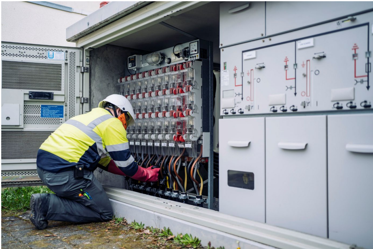
Abbildung 4: Jürgen Blank und sein Team haben in Rekordzeit ausgewählte Stationen mit SMIGHT Grid2 ausgestattet.
